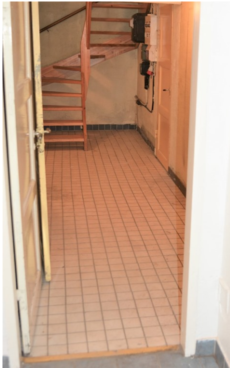
Hall i källare
